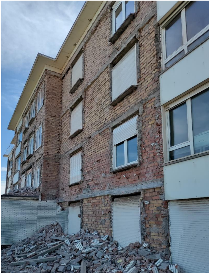
Figuur 5. Werfbeeld na de afbraak van het buitenspouwblad (september 2021).
