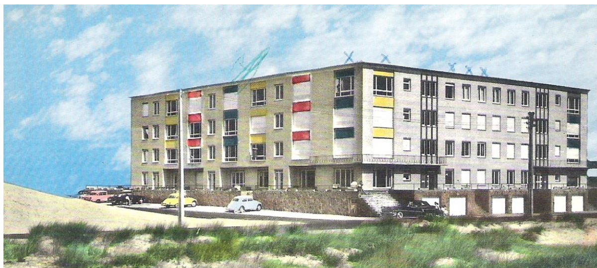
Figuur 1. Postkaart daterend van kort na de bouw, vermoedelijke jaren 1950. Hoek van de WWZ- en de ZZO-gevel. De gekleurde vlakken waren oorspronkelijk beschilderde pleister. Kort na de bouw werden ze echter bekleed met Glasal-panels omwille van vocht(- en mogelijk zout-)problemen.
