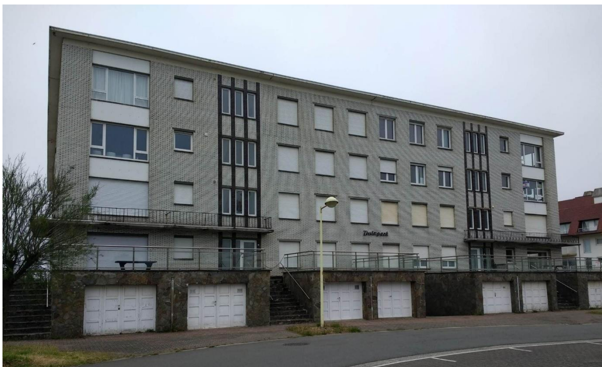
Figuur 2. ZZO-gevel in 2019, vóór de start van de renovatiewerkzaamheden.
