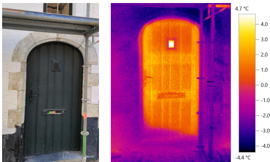
Figuur 8. Bij de voordeur tekenen de achterliggende stijlen zich af. Door het breken en verzakken van het linkerdeel van de dorpel is een spleet ontstaan. Blijkbaar trekt langs die spleet koude lucht naar binnen, zodat de linkeronderhoek van de deur een stuk kouder is dan de rest. Het kijkgaatje boven in de deur is dan weer een warm element.
