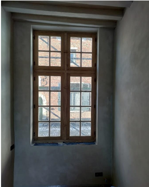
Figuur 4. Binnenzicht van het raam naast de voordeur.
