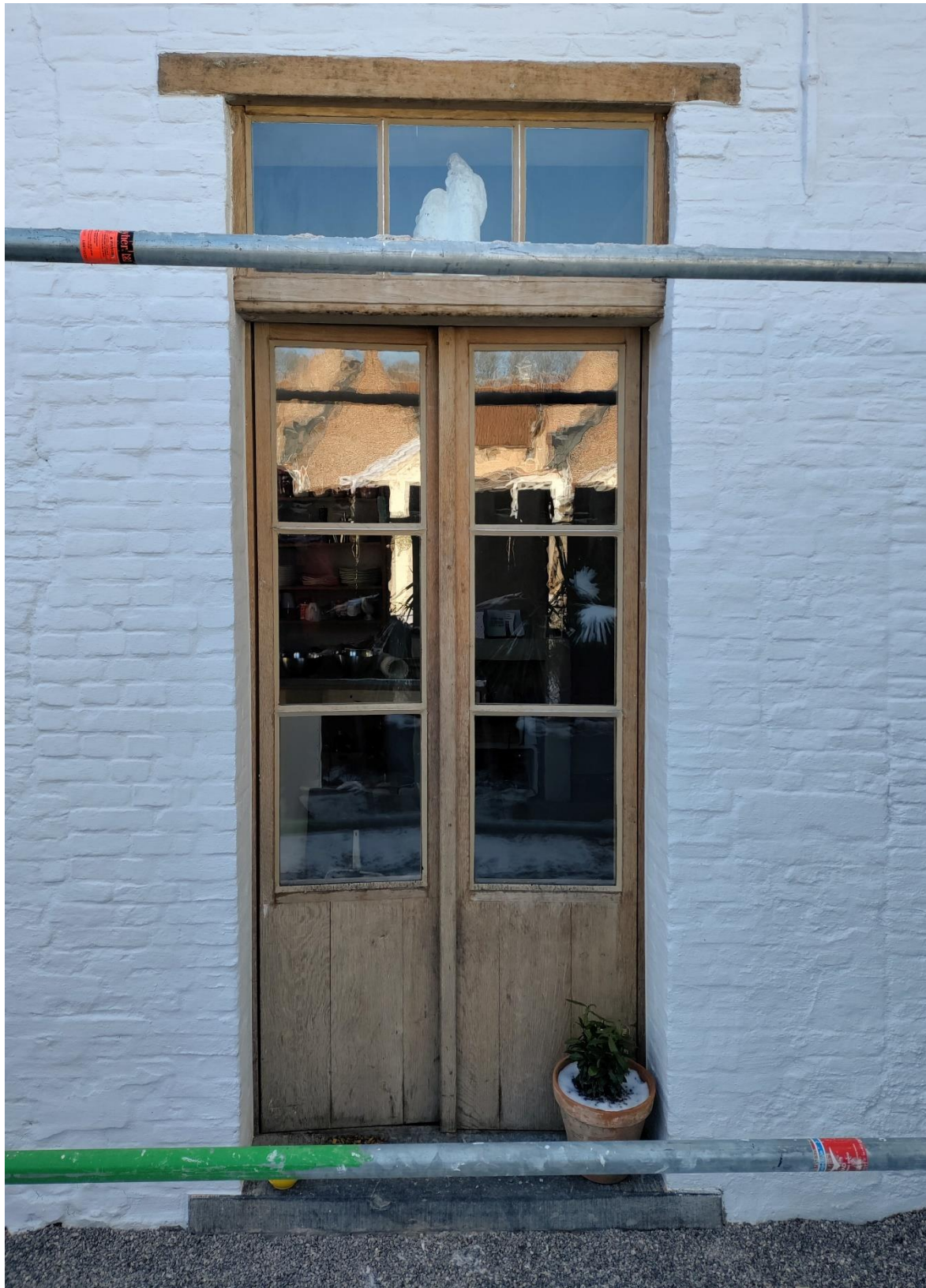
Figuur 6. Deurraam met driedelig bovenlicht in de achtergevel.
