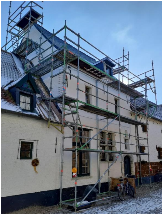
Figuur 1. Voorgevel (februari 2021).
